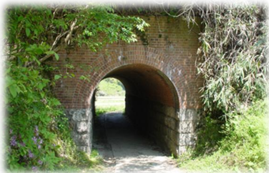
大仏鉄道梶ヶ谷隧道
