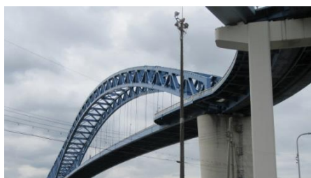
千歳橋 橋長:950m 平成15年完成
