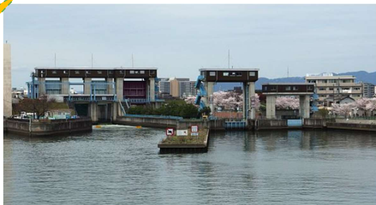
左から毛馬水門、毛馬閘門、予備閘門
