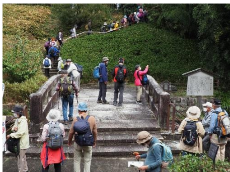
竹林公園に移築された百々橋
