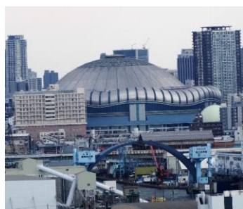
京セラドーム大阪・尻無川水門
