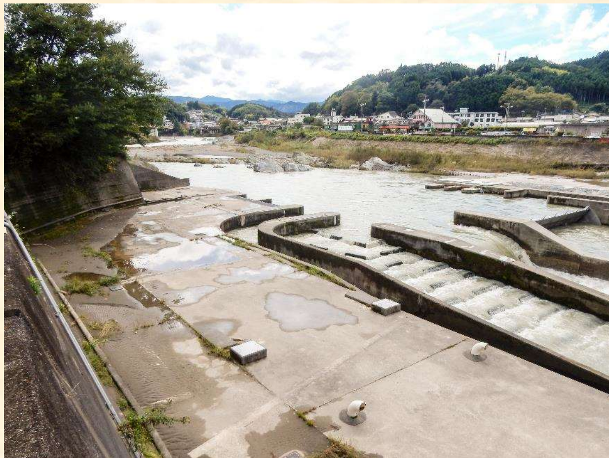
手前左の水路が吉野川分水取水口
