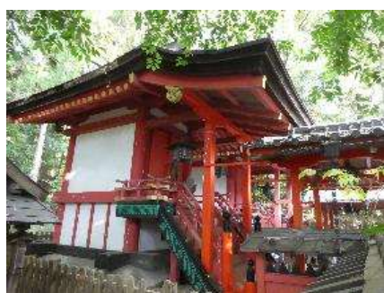
重要文化財 松尾神社本殿
