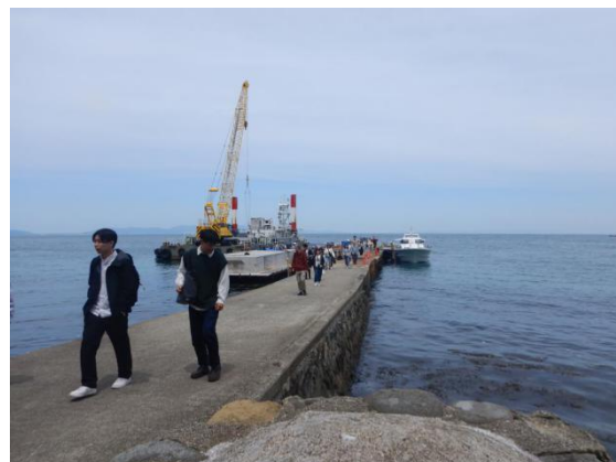
栈橋は工事中です
