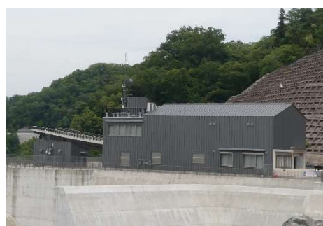
ダム管理事務所
