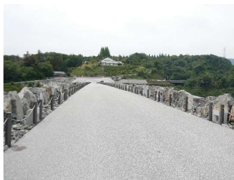
ダム天端道路
