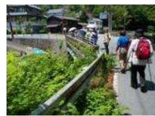
下音羽川の橋
