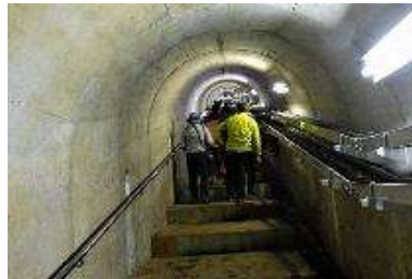
蔵王ダムの地下通路への階段
