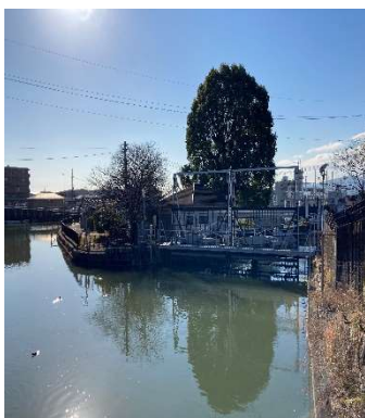
墨染水力発電所
