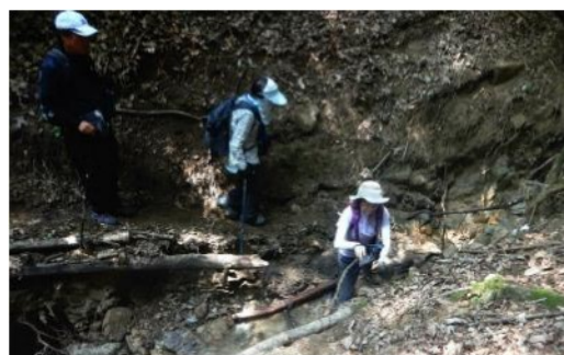
道が崩壊している、慎重に
