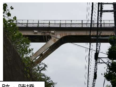
黒髪山トンネル跡・陸橋
