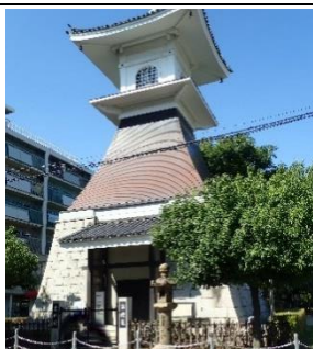
S49 に移設再建された高灯籠
