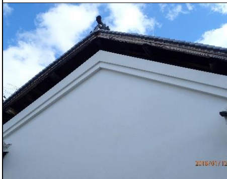
火災時に屋根を落とす置き屋根
