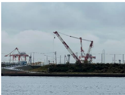
大阪万博施設建設中
