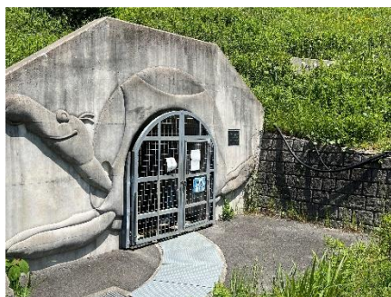
1号排水トンネル
