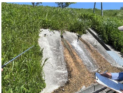
排水路（地表部分）
