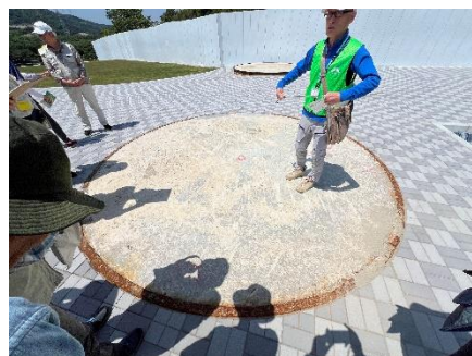
地すべり抑止の鋼管杭
