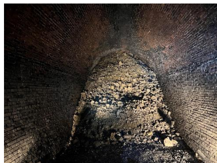
工事中に明治期のトンネル発見
