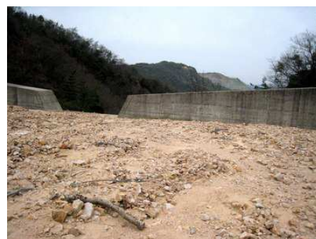
座頭谷の土砂を受止める最後の堰堤
