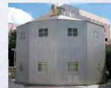
ガスホルダ 発生したバイオガスを一時貯留するものです。
