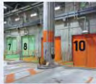
持込ごみプラットフォーム 搬入された粗大ごみ及び弾性ごみをごみビットに投入します。
