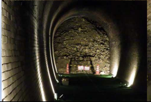
旧大阪鉄道 亀の瀬隧道
