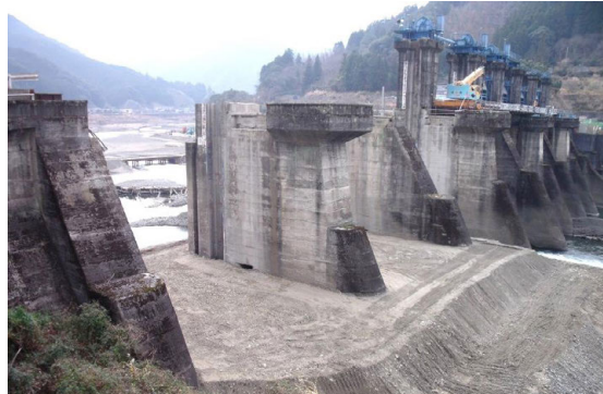
写真4 爆破後の荒瀬ダム水門柱(右岸側) (2014年1月11日 著者撮影)
