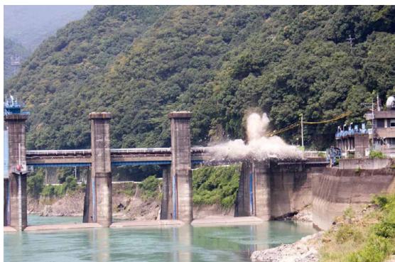
写真1 荒瀬ダム水門の発破直後(右岸側) (2013年9月 小山賢吉氏(日本報道写真連盟会員)撮影・提供)
