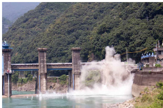
写真2 荒瀬ダム水門柱爆破のコンクリート破片の飛散(右岸側) (2013年9月 小山賢吉氏(日本報道写真連盟会員)撮影・提供)
