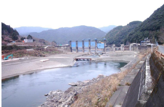
写真3 爆破された荒瀬ダム水門(右岸側) (2014年1月11日 著者撮影)
