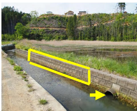
開削する護岸 矢印は通水孔
