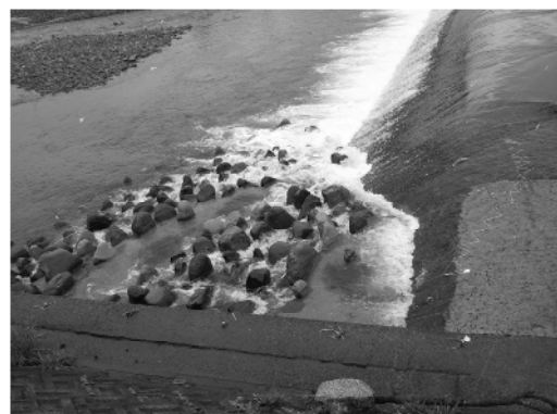
筆者が施工管理した小わざ魚道；プールに黒く見えるのはすべてアユ（鳥取県日野川）
