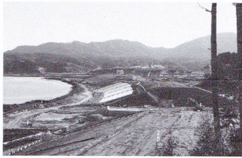
図1 宮城県気仙沼市小泉海岸に建設中の巨大防潮堤（高さ14.9m、底辺最大幅90m。2016年10月2日、横山勝英さん撮影）
