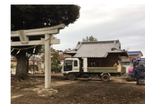
栃木県佐野市 坂和神社【撤去後】 2019年10月24日
